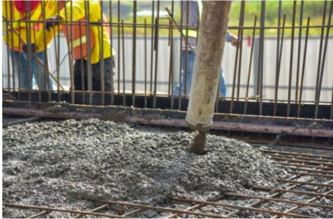
Gambar 10.1. Metode Kerja Beton Siklop (Megacon Beton, 2021)
