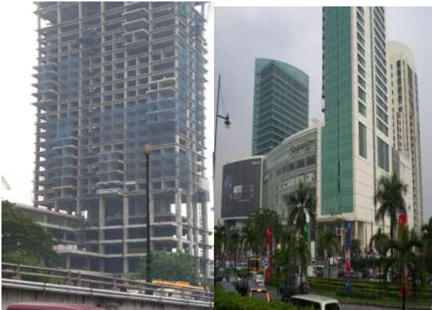
Gambar 2.1. Gedung Tinggi Multi Fungsi di DKI Jakarta
