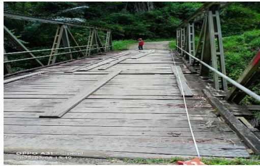
Gambar 1 Jembatan Sungai Sangpiak
