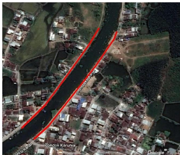
Gambar 1. Lokasi Penelitian Pembangunan Tanggul Kanal Sinrijala
