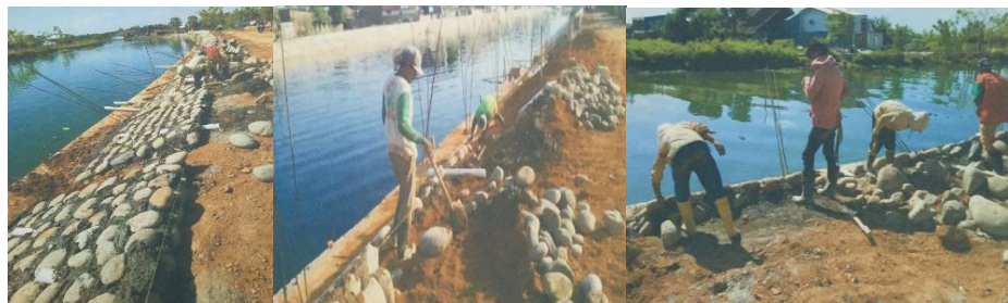
Gambar 3. Pekerjaan pemasangan tanggul batu kali kanal Sinrijala
