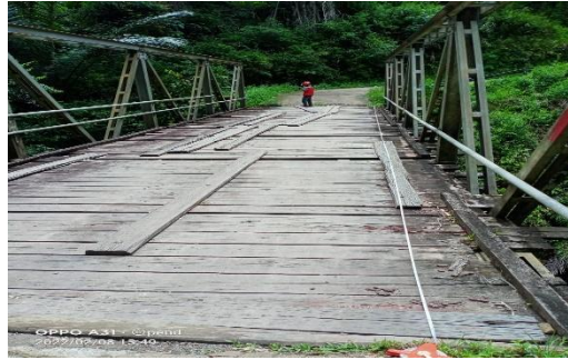
Gambar 1 Jembatan Sungai Sangpiak
